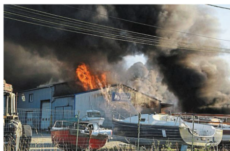
Le 2 juillet, un violent incendie a détruit deux bâtiments situés dans la zone artisanale de la Ville-au-Coq. Parti d'un garage automobile, le feu s'est ensuite propagé au chantier du Grand Lague.
